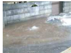
◀ マンホールから下水が溢れる被害
